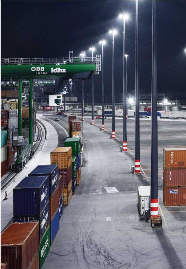
ÖBB Container Terminal, Wolfurt / Austria, 2019 / A3 Jenewein Ingenieurbüro GmbH
